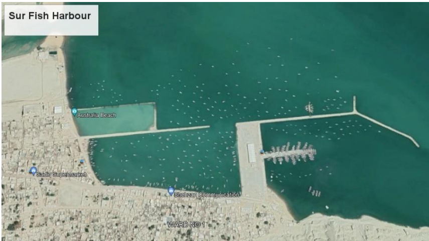
Fig. 17. Fish Harbour at Sur
